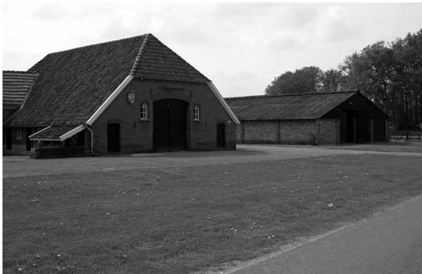
Het erva Wagenvoort nu. De oude boerderij stond op de plek van de schuur rechts
